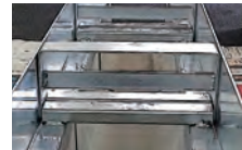
受枠用補強金具設置例
