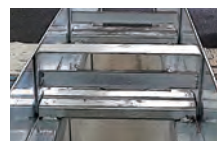
受枠用補強金具設置例
